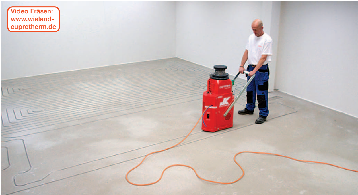
Fräsmaschine im Einsatz – sauberes Arbeiten. Das Fräsgut wird sofort abgesaugt
