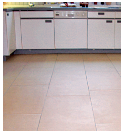
Fußbodenheizung mit neuem Belag – schon nach wenigen Tagen
