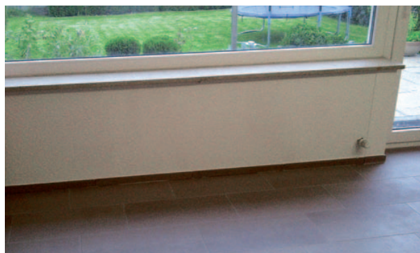
Nachher: Heizkörper entfernt, finaler Oberbelag
