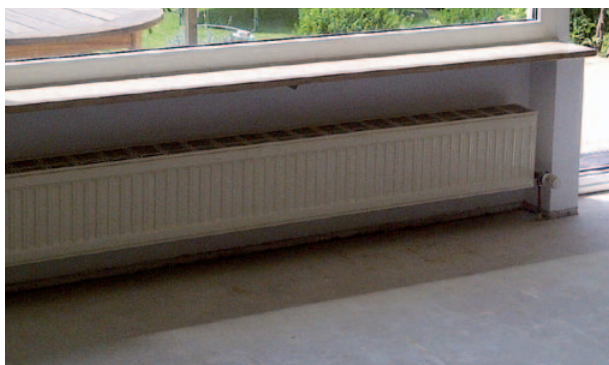
Vorher: Belag entfernt
