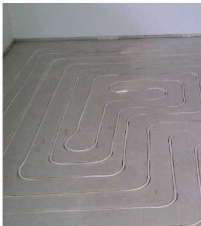
Eingelegte cuprotherm CTX-Rohre (mit Ummantelung)
