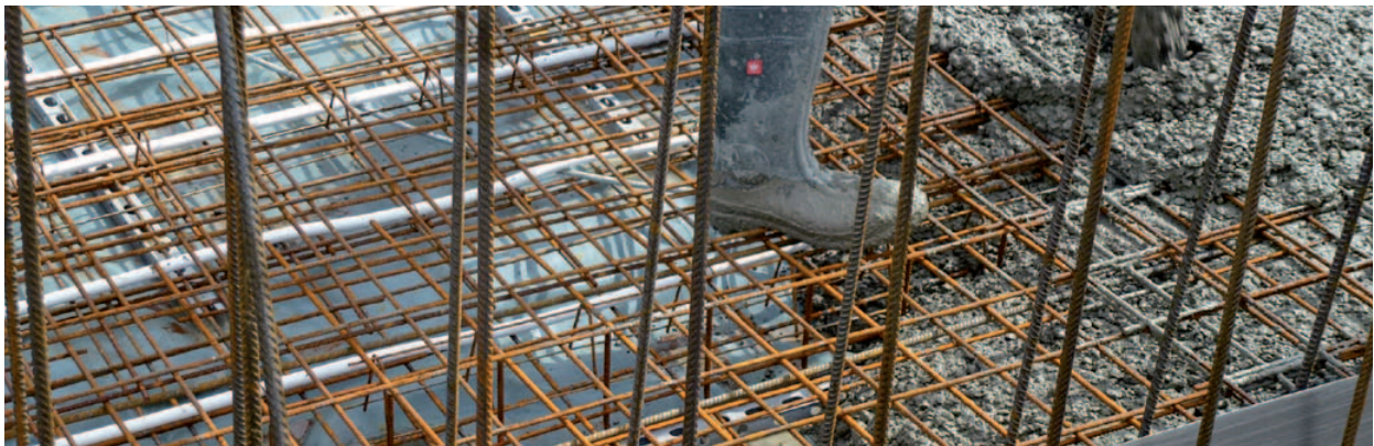
Heizungsrohre und Mattenbewehrung werden abschließend in Beton eingebettet
