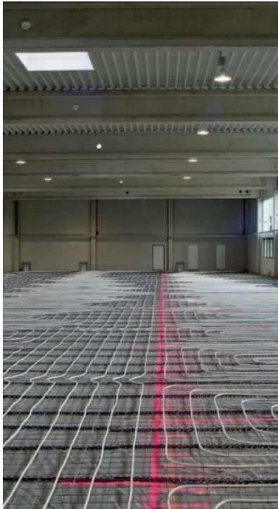
Rohre auf unterer Bewehrungsebene, Hallenboden komplett beheizt
