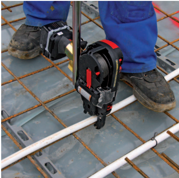
Rohrbefestigung mit Bindemaschine
