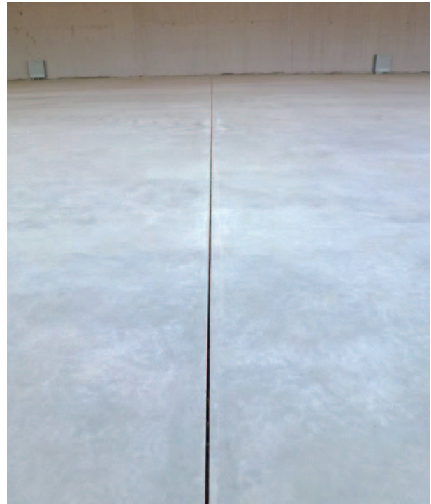
Nachträglich eingeschnittene Betonfläche (Scheinfuge)
