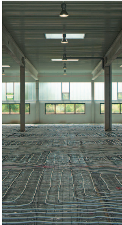
Rohre auf unterer Bewehrungsebene, Hallenboden komplett beheizt
