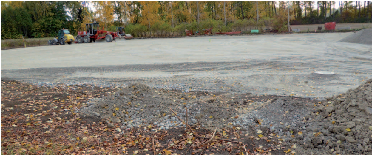
Arbeiten am Untergrund
