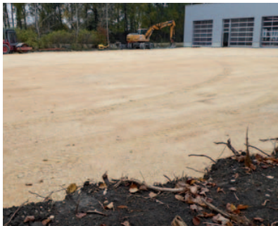
Schottertragschicht auf verdichtetem Untergrund
