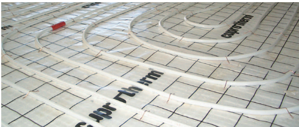
CTX-Heizungsrohre, auf druckfester Dämmung verlegt und mit Doppelanker befestigt
