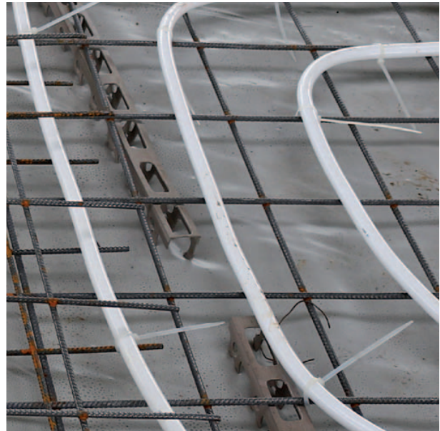
CTX-Rohre mit Kabelbindern befestigt
