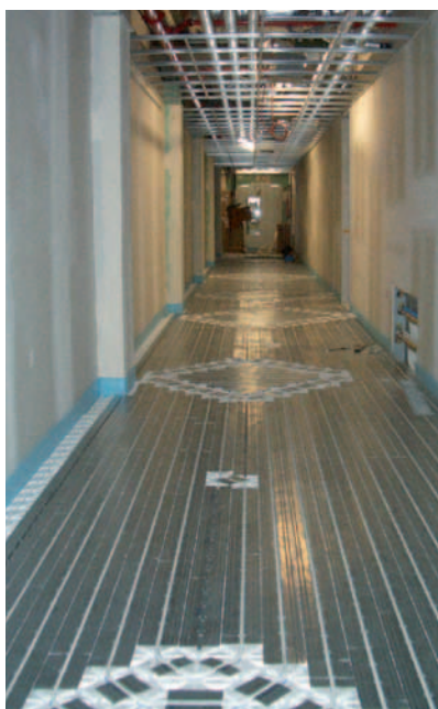
Verlegte CTX-Rohre
