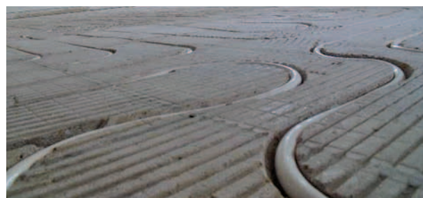
CTX-Rohre in gefrästen Nuten verlegt
