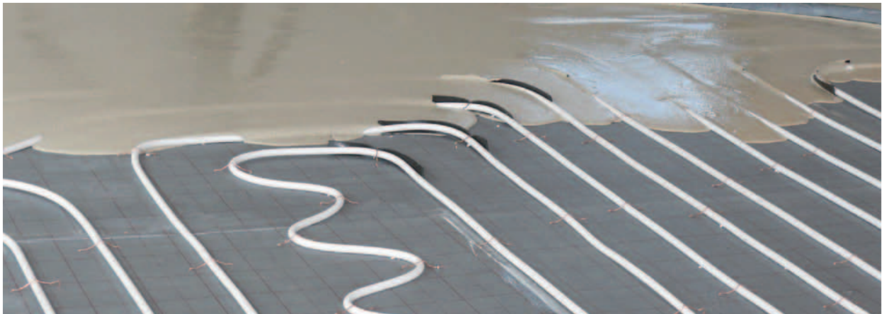
cuprotherm mit Fließestrich
