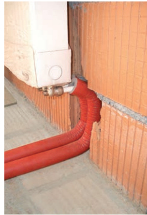
Heizkörperanbindung (z. B. CTX 14 x 2)
