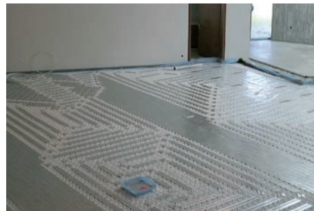
Trockenbausystem (Renovierung Kirche Mater Dolorosa, Langenau, CTX 14 x 2)
