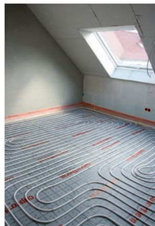
Fußbodenheizung/-kühlung mit Nassestrich (Wohnbereich, CTX 14 x 2)
