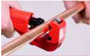
1. Kürzen Sie das Kupferrohr
