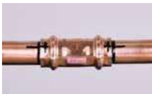
13. Markieren Sie die Verbindung
