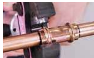
11. Führen Sie den Fitting in die Pressbacke
