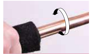
4. Reinigen Sie das Ende des Rohres
